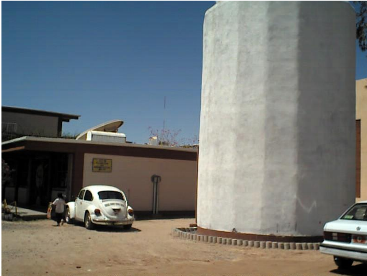
ESTACIÓN DE OBSERVACIÓN SOLAR, EOS
