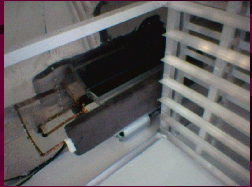
Figura 12.- Localización del fain-col, para calentar el aire.
