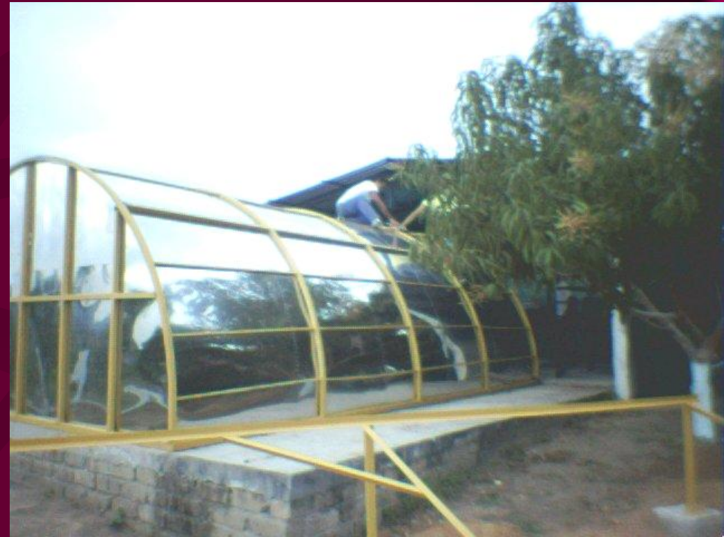
Figura 6.- Vista lateral y frontal del deshidratador cubierto con lamina de acero inoxidable tipo alimenticio.
