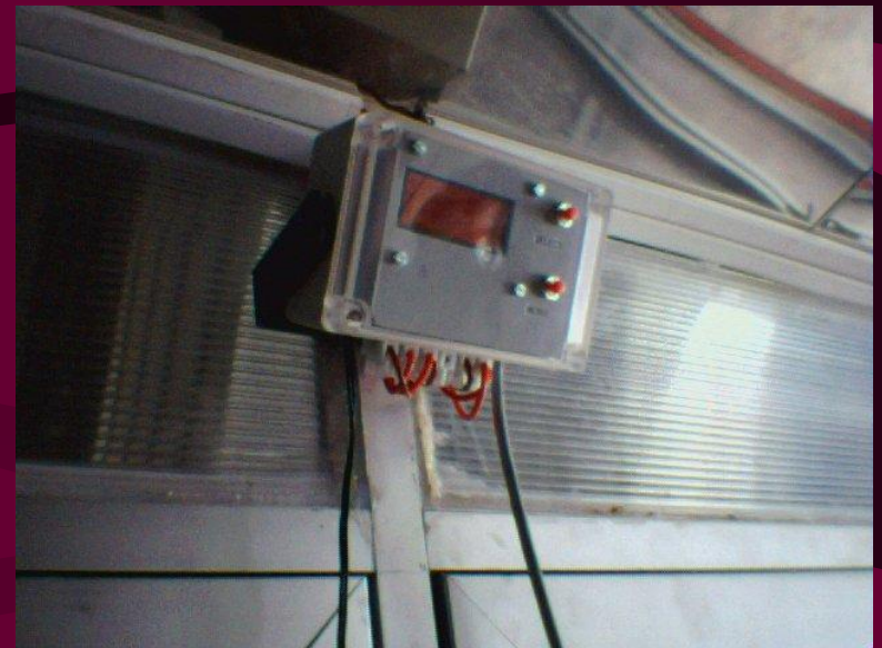
Figura 10.- Control para obtener la temperatura y la humedad relativa del aire
